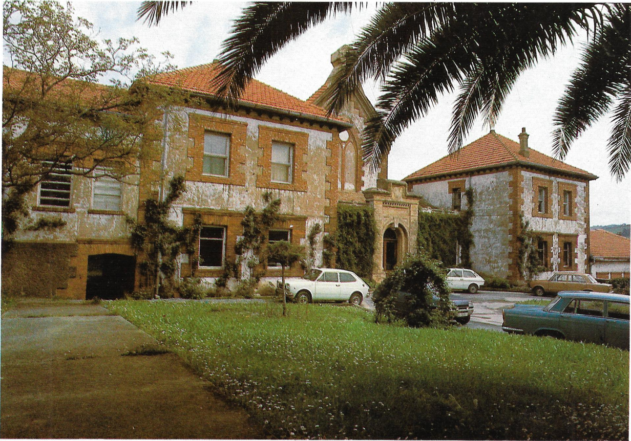
Fachada del Hospital Psiquiátrico de Bermeo, proyectada por Don Nicolás de Achúcarro.
